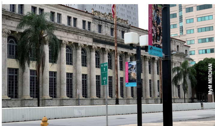
Arriba, el Dr. Eduardo Padrón. Abajo “el edificio más bello por dentro de todo Miami”. Albergará la Escuela de Arquitectura y otras carreras creativas, una vez finalice su rehabilitación
