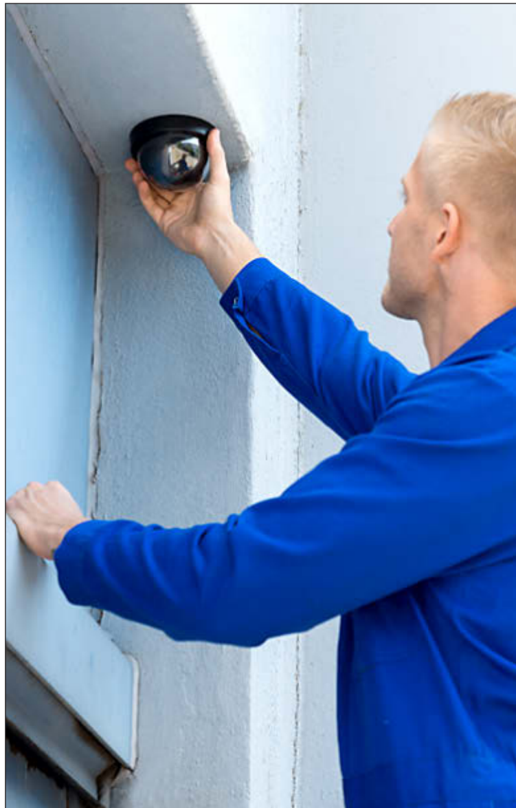
Un operario durante la instalación de una cámara de vigilancia. ISTOCK
