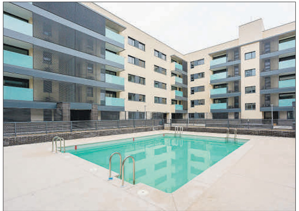
Piscina de la primera promoción BtR en Torrejón de Ardoz que entrega Aedas Homes a Ares. EE
