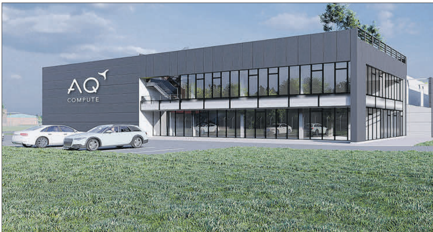
Centro en construcción de AQ Compute, rama de centro de datos de Aquila Capital, en Noruega. EE
