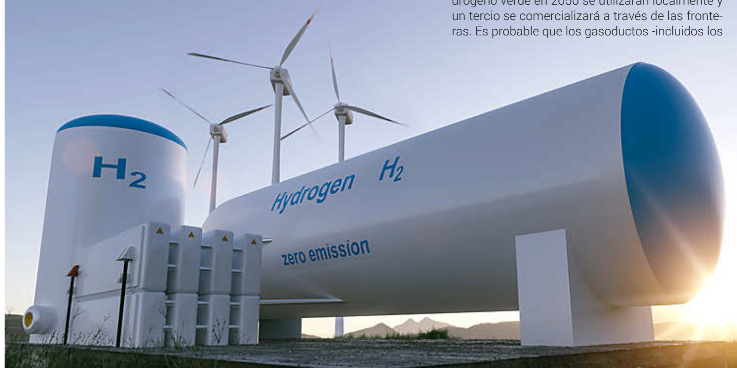
Tanques de hidrógeno para la producción de energía renovable.
