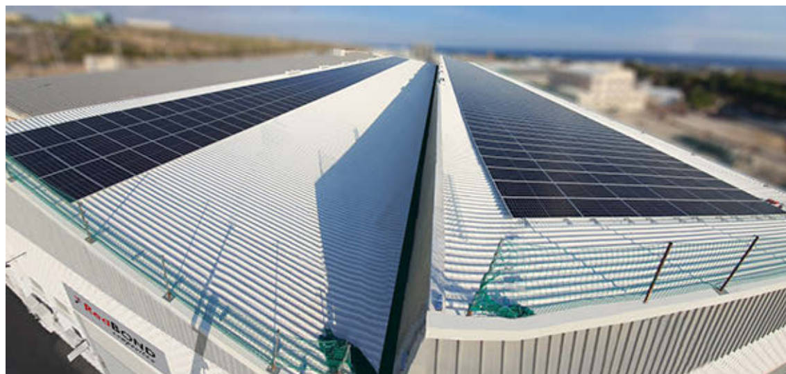
Cubierta solar fotovoltaica RedBOND Composites en Alicante.
