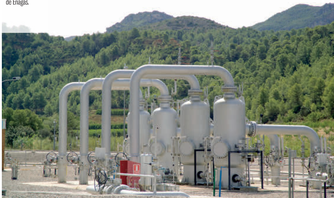
Infraestructura de Enagás.
