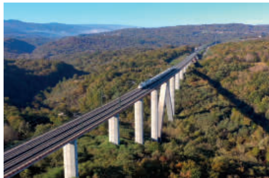
De izq. a dcha.: planta fotovoltaica en Chile y Tramo Miamán-Ponte Ambía del AVE Madrid-Galicia.
