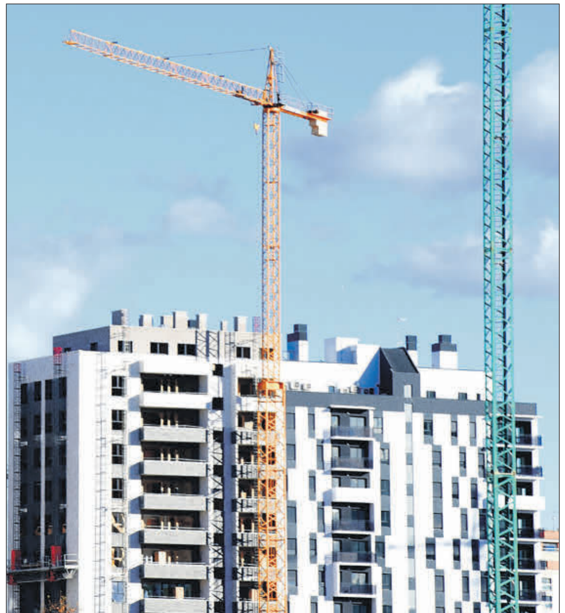
Viviendas en construcción. ISTOCK
