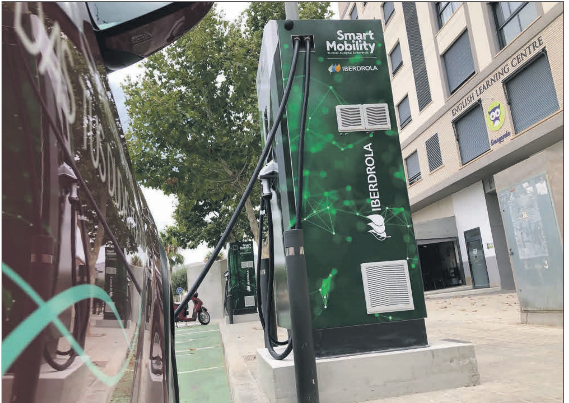
Punto de recarga de vehículo eléctrico en Villajoyosa (Alicante).
