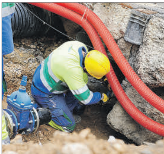
Trabajos en la red de agua. EE
