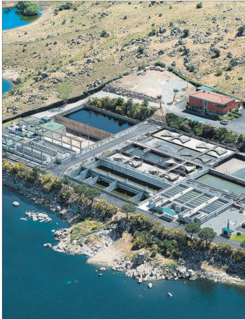
Vista aérea de una depuradora. EE
