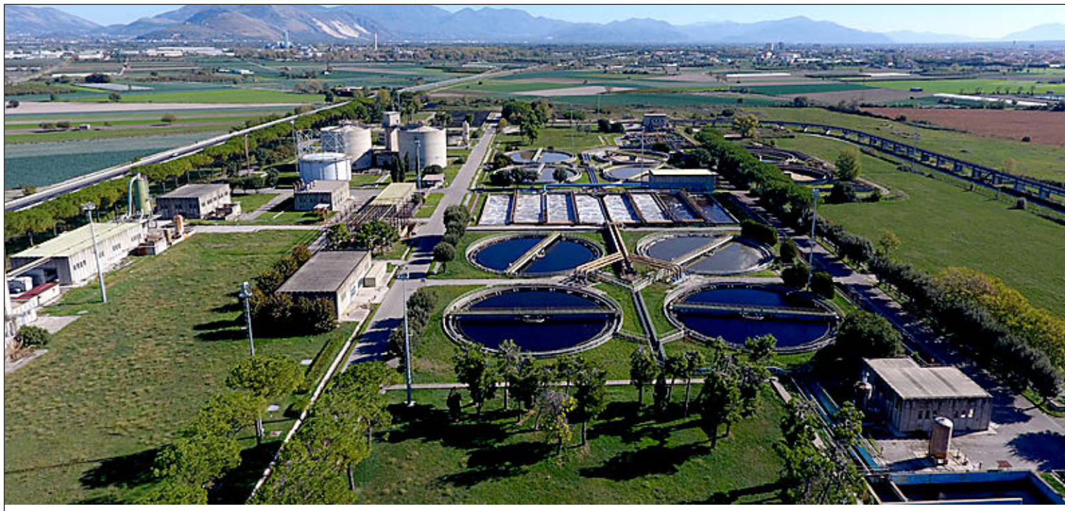
Estación de tratamieto de aguas en Acerra (Italia), que gestiona Depuración de Aguas del Mediterráneo (DAM). EE
