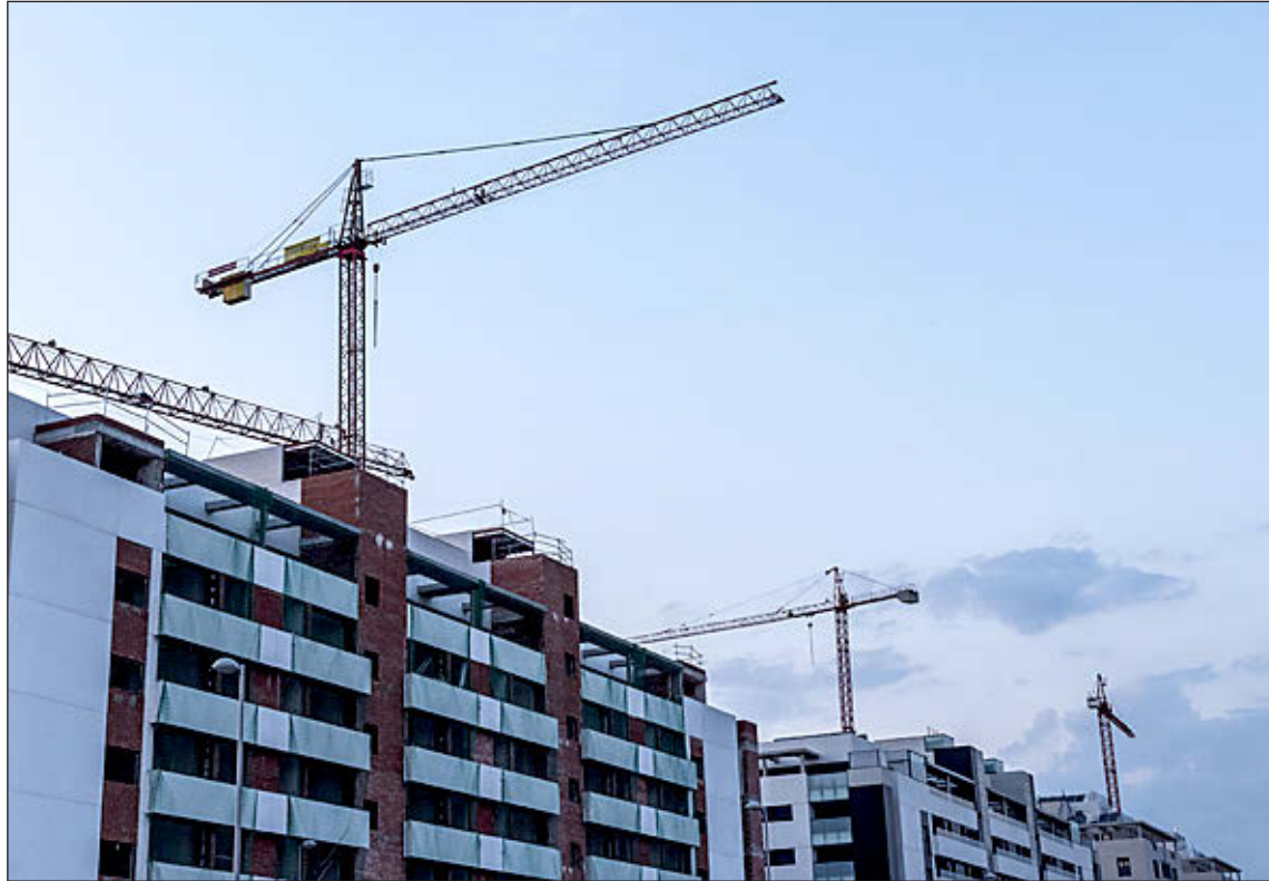
Urbanizaciones de viviendas en construcción. DANIEL G. MATA
