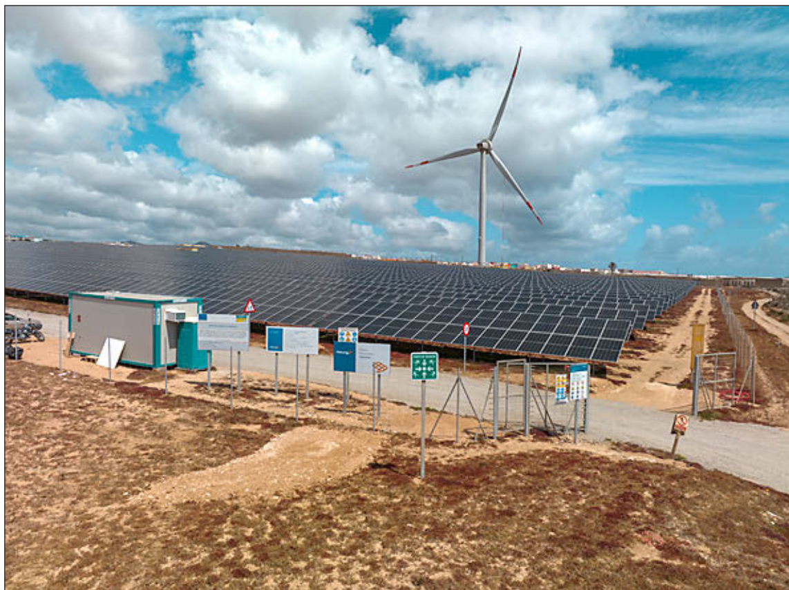
La planta fotovoltaica de Salinetas de Naturgy, en Gran Canaria. EE
