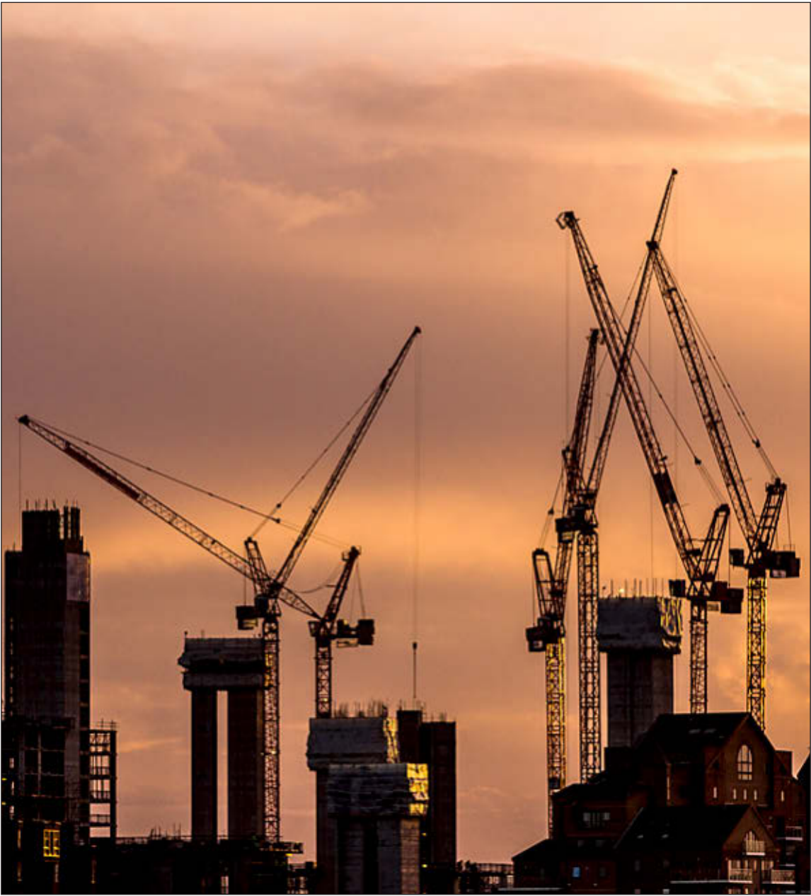
Proceso de construcción de edificios residenciales. ISTOCK
