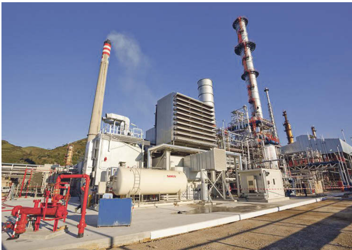
Cogeneración de Abengoa. eE
