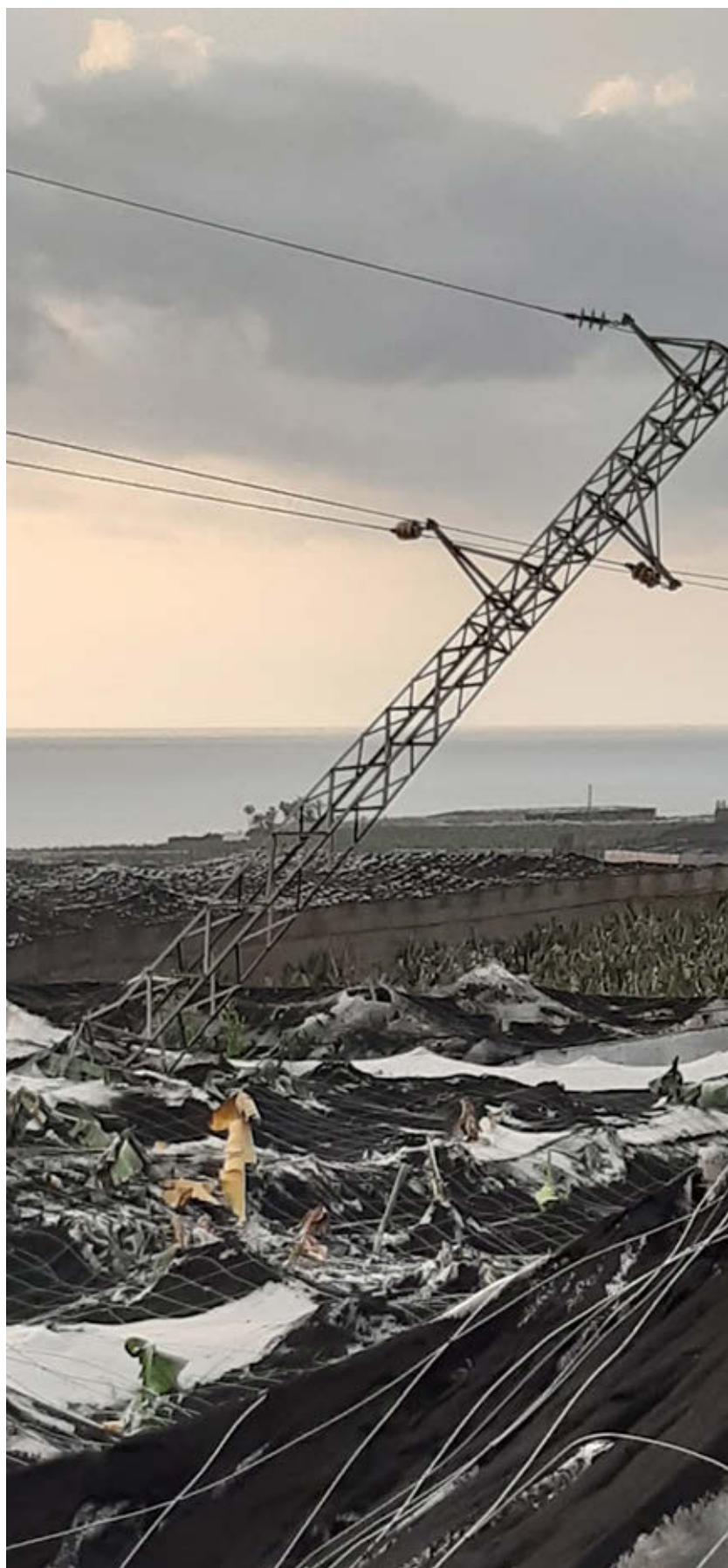
Caída de una de las torres de media tensión en La Palma. eE
