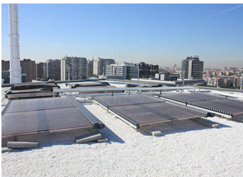
Instalación solar térmica de tubos de vacío.
