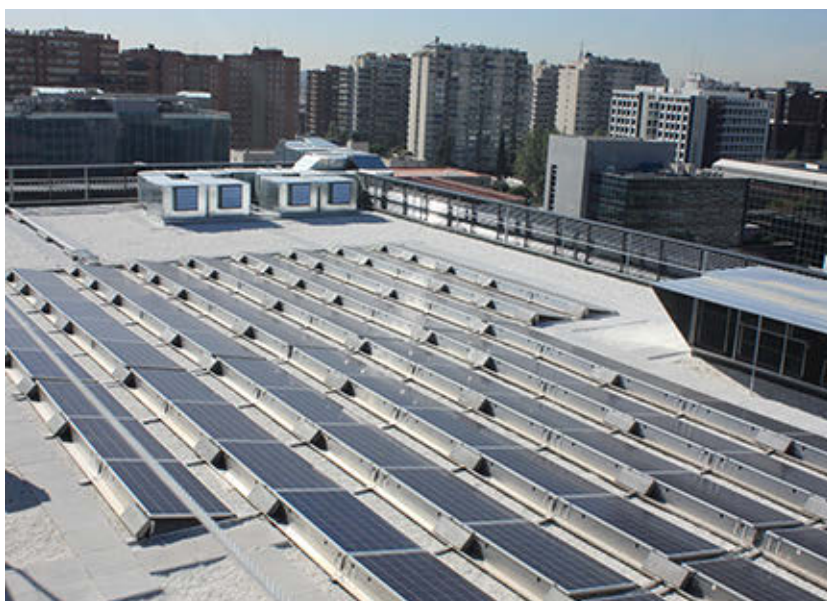
Instalación solar fotovoltaica para autoconsumo.
