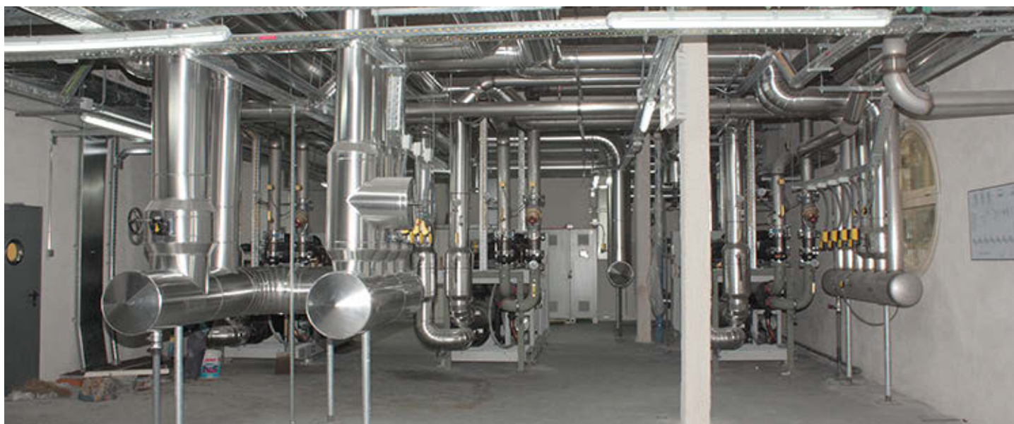
Conexión hidráulica producción de frío.
