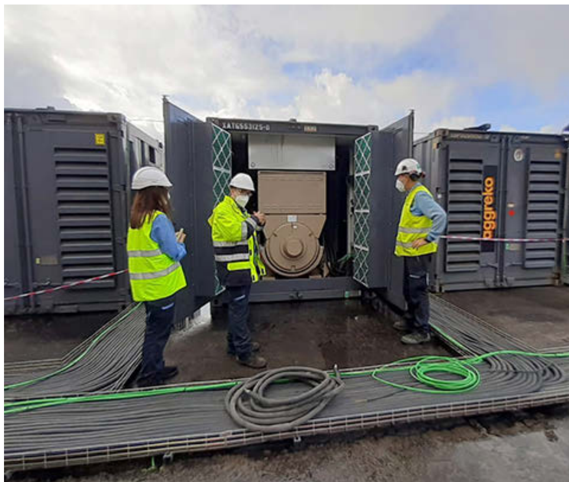
Técnicos de Endesa junto a los contenedores de la central térmica portátil de Los Llanos de Aridane. eE
