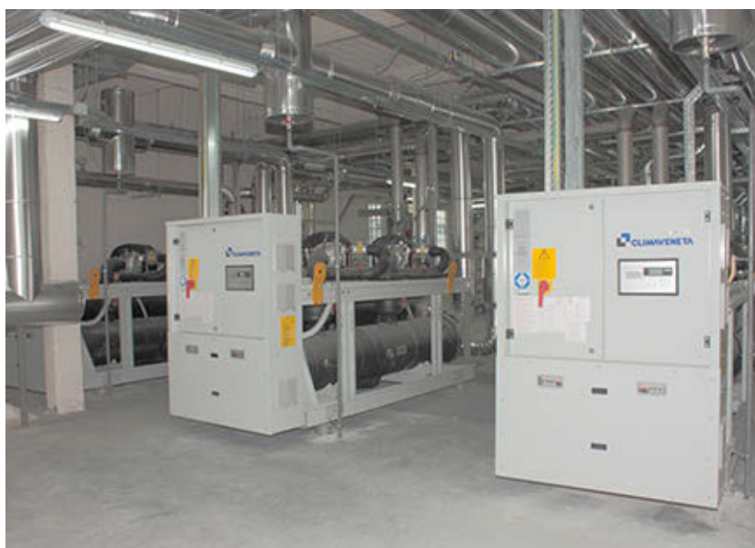
Grupos frigoríficos de condensación Climaveneta de Mitsubishi Electric.
