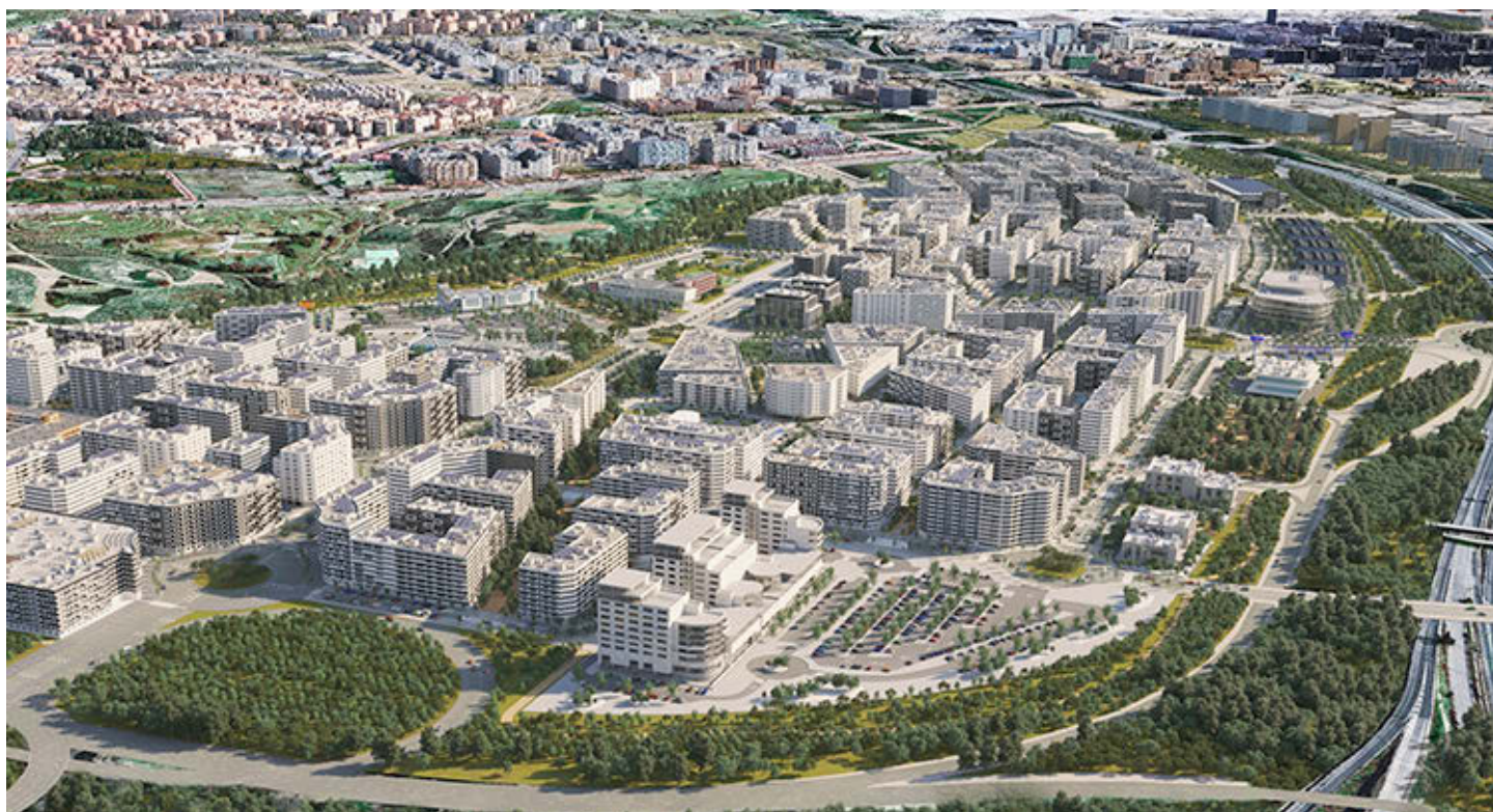
Valdecarros ya ha comenzado la ejecución de las obras de urbanización de la segunda y tercera fases. Europa Press
