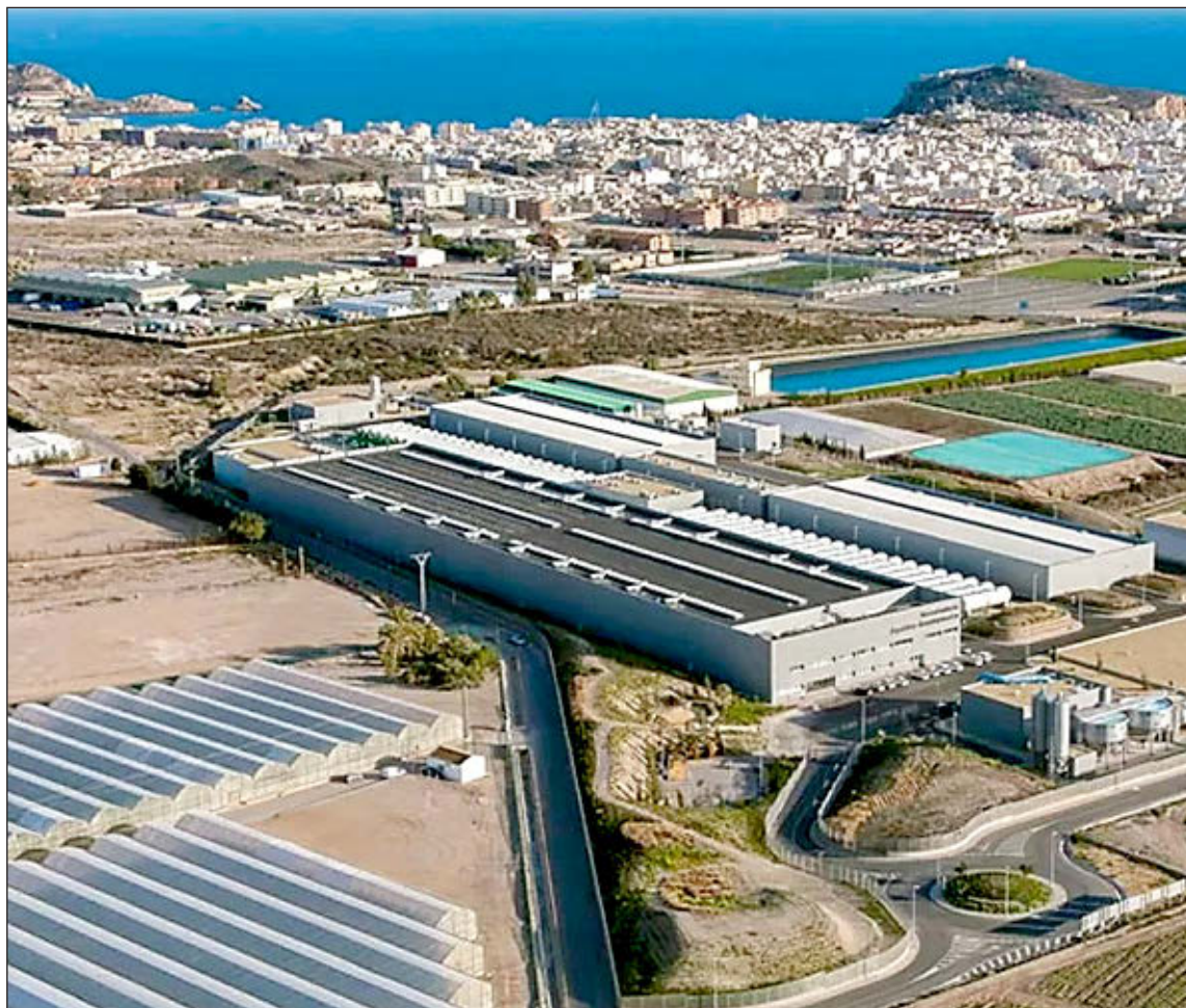
Complejo de una planta desalinizadora.
