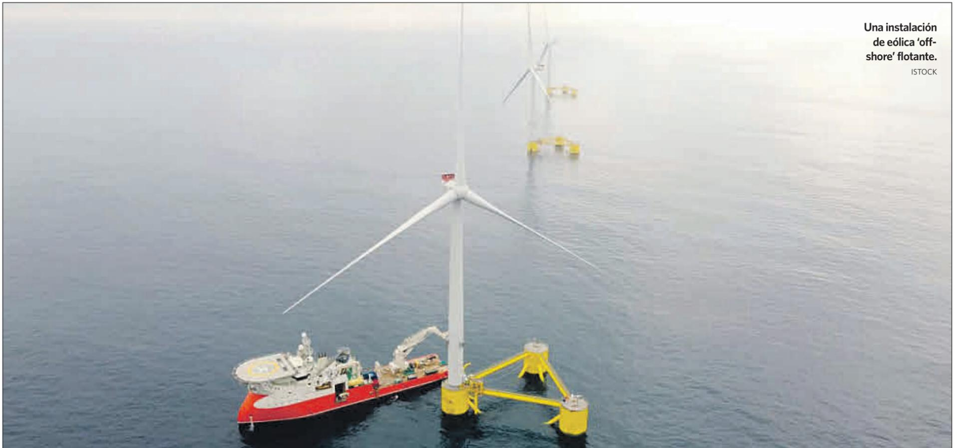
Una instalación de eólica 'off-shore' flotante.
