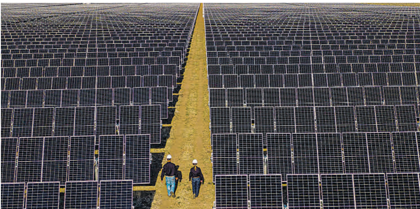
Vista aérea de la planta fotovoltaica de Jicarilla 2, Nuevo México, EEUU.
