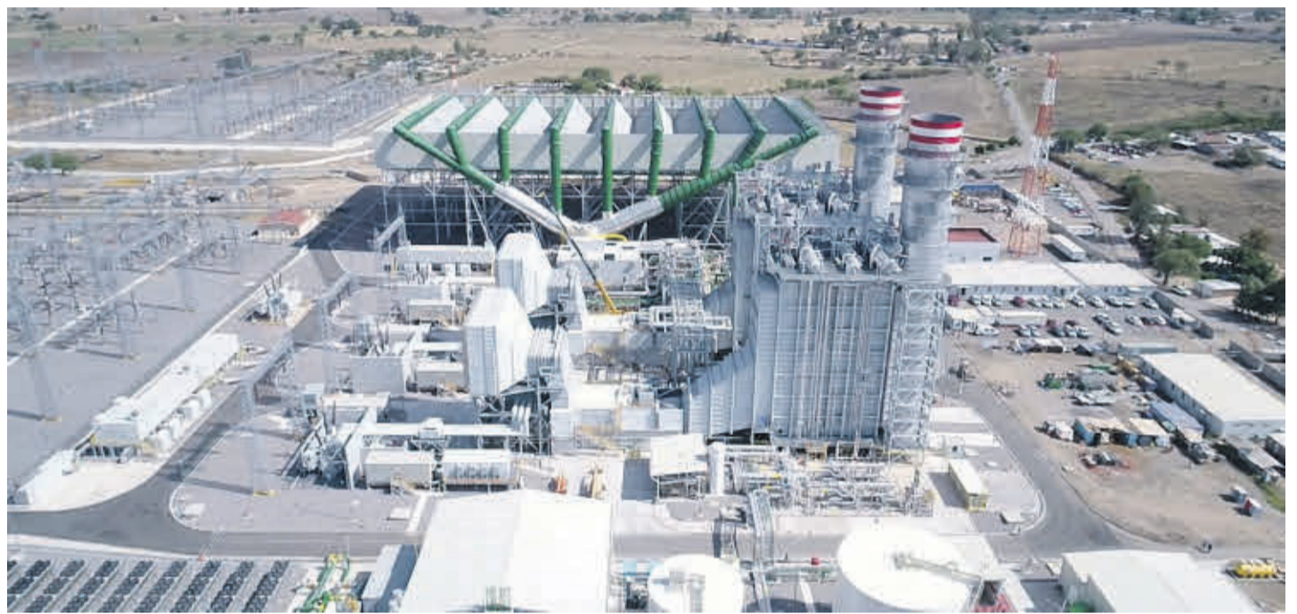
Planta de ciclo combinado alimentada con turbinas de última tecnología en Tierra Mojada, México.
