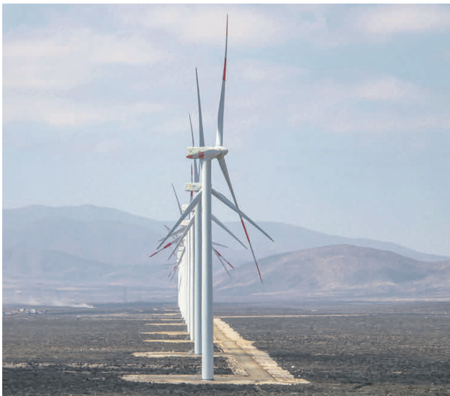
Parque eólico de Cabo Leones III en el desierto de Atacama, Chile.
