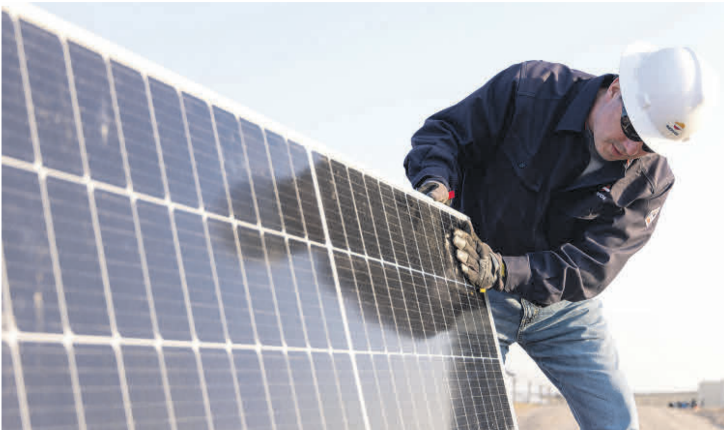
Comprobación de placas en la planta fotovoltaica de Jicarilla 2.
