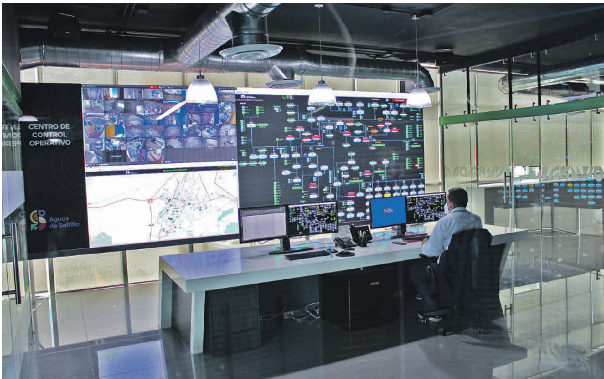
El Centro de Control Operativo de Aguas de Saltillo.
