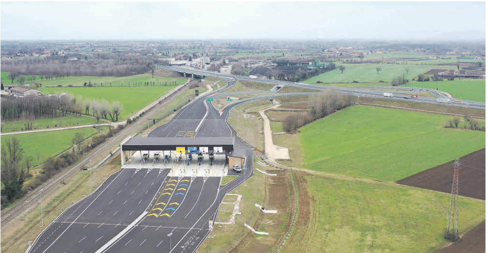
Autopista Pedemontana Veneta (Italia).
