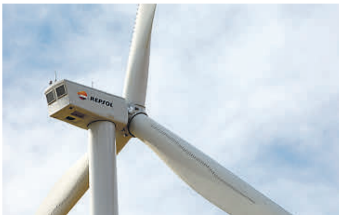
Detalle de un aerogenerador.
