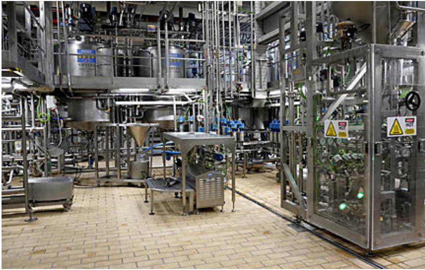
La planta a escala permite al centro hacer pruebas semiindustriales. eE
