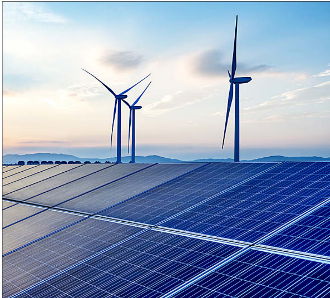
Planta fotovoltaica y generadores de energía eólica. ISTOCK
