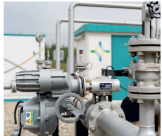
Equipo y maquinaria de Redexis.
