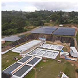
La compañía española RIC Energy, ha desarrollado y construido un sistema de microrred en la planta potabilizadora de Mzuzu (Malawi), que abastecerá de agua a más de 200.000 personas. El proyecto, que consta de 1,3 MW fotovoltaicos y de un sistema de baterías de 4,5 MWh, distribuido en dos depuradoras y cinco estaciones de bombeo, es actualmente uno de los proyectos de microrred más ambiciosos del continente africano. Se espera que
