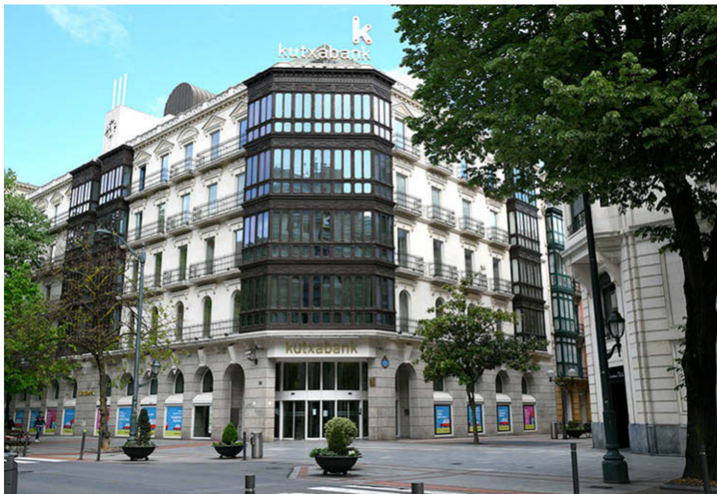
Sede de Kutxabank, ubicada en la Gran Vía de Bilbao. Domi Alonso
