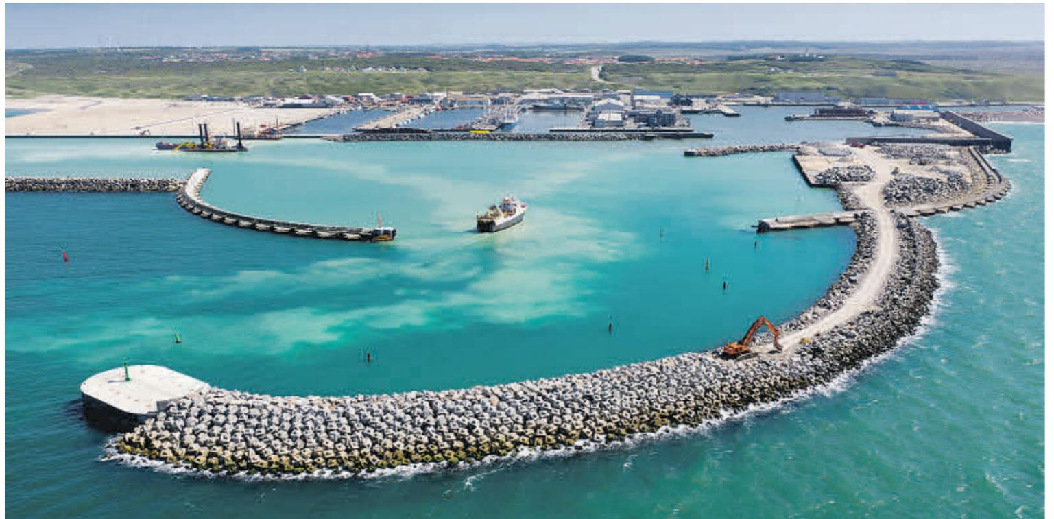
Aplicación de Cubipod en el proyecto de ampliación del puerto de Hanstholm, Dinamarca. CORTESÍA DE PER AARSLEFF/PUERTO DE HANSTHOLM.
