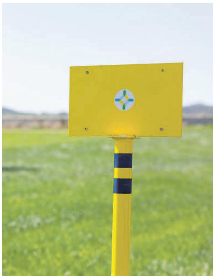
Señalización de gasoducto de transporte de gas natural de Redexis. REDEXIS
