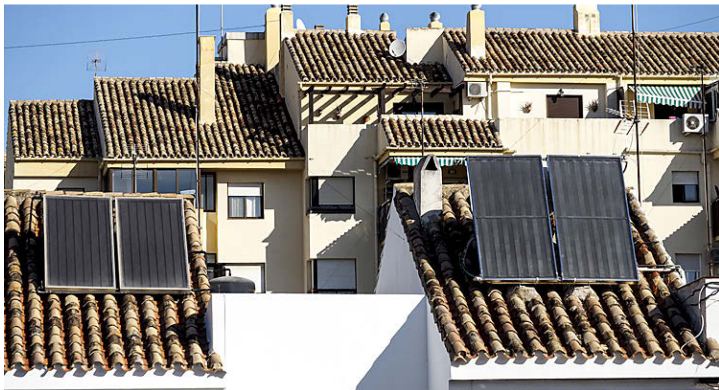
El autoconsumo de energía fotovoltaica es más viable con placas solares en viviendas unifamiliares.
