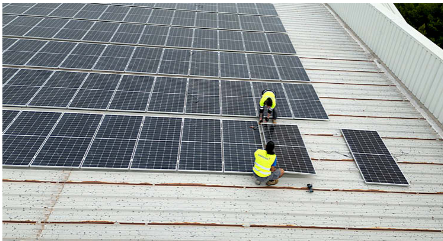
Varios trabajadores de la firma durante la instalación en la cubierta de la empresa del sector cerámico Arciblansa en Alcora.
