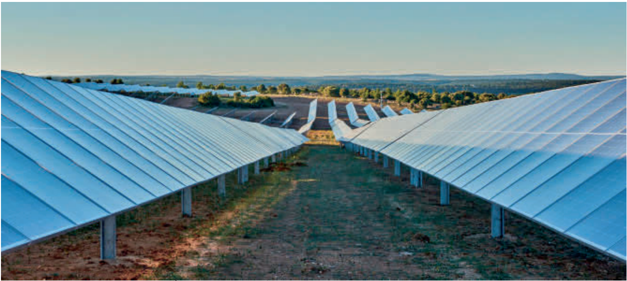
Planta solar fotovoltaica 'Canredondo', en Guadajajara.
