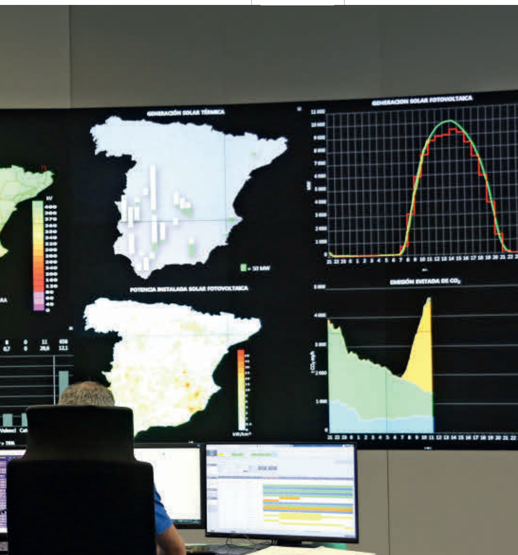
Centro de Control de Energías Renovables (Cecre) de Red Eléctrica
