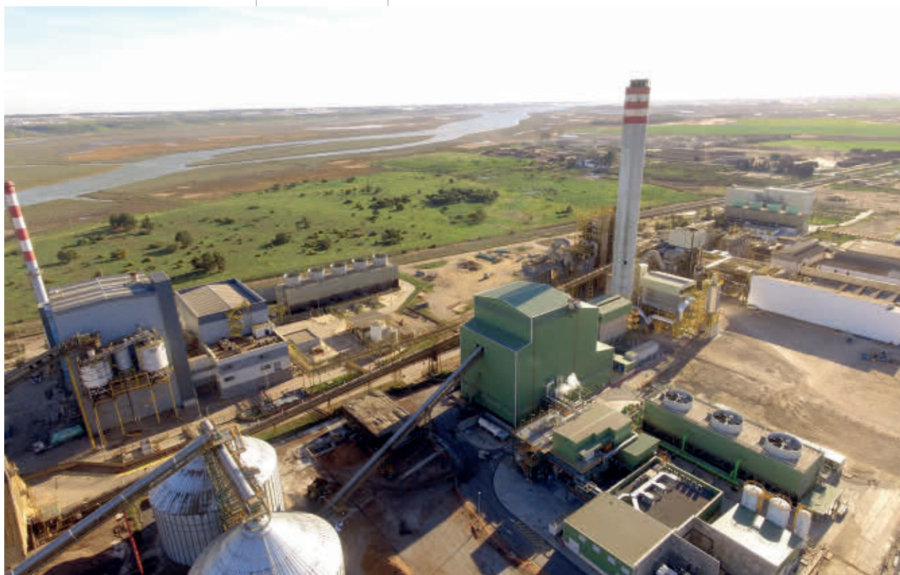
Instalaciones de la planta de Huelva de Magnon
