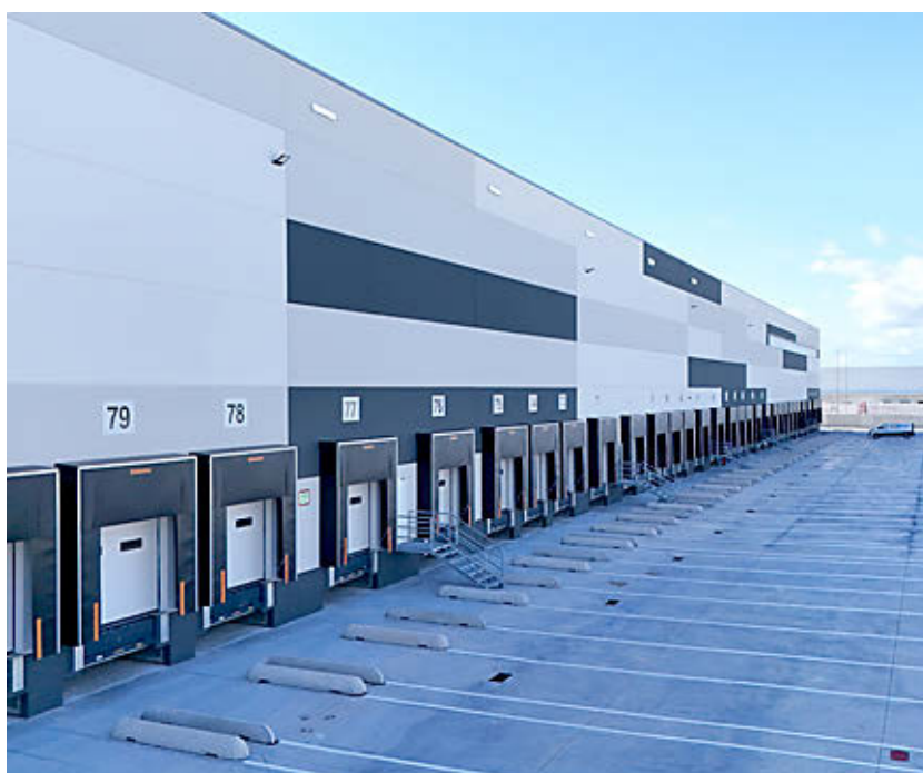
La nueva planta de Dia en Dos Hermanas (Sevilla) cuenta con 101 muelles de carga. eE
