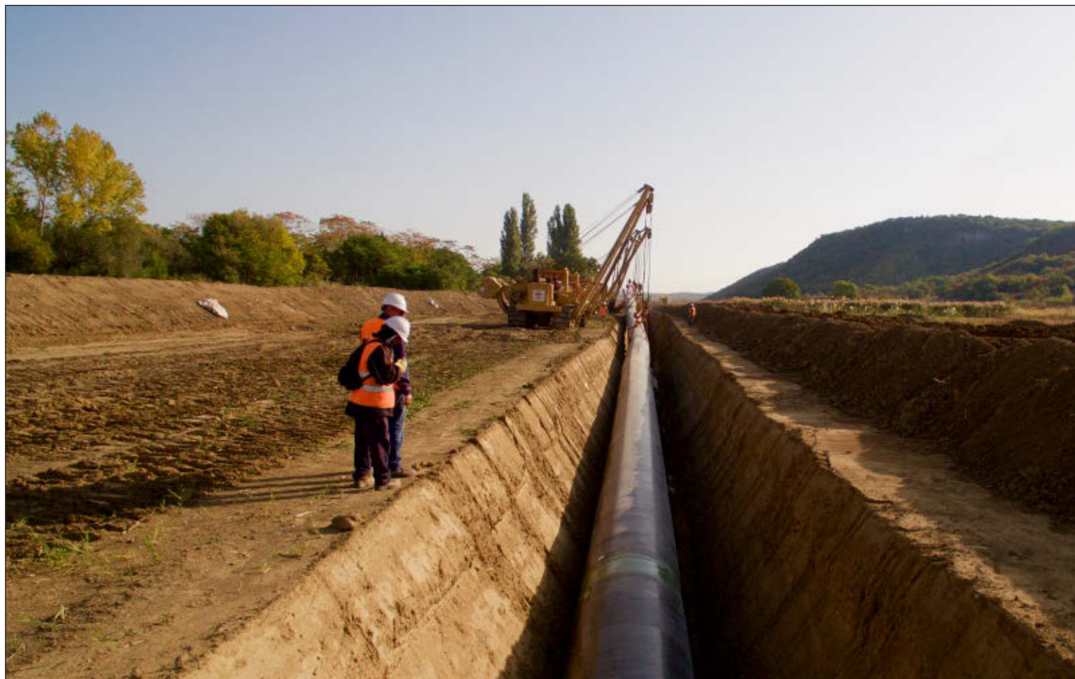
Obras de instalación de un gasoducto. EE
