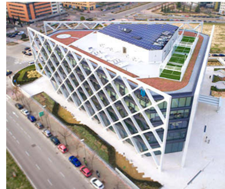
Azotea con dos pistas de pádel, pista de 'running' y área de ejercicio al aire libre con máquinas. GMP
