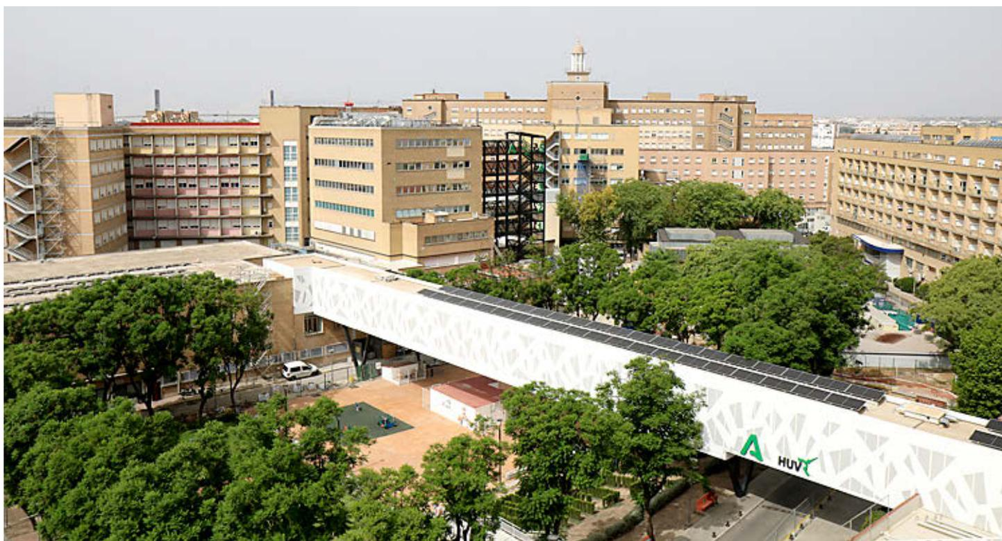
La planta solar fotovoltaica de autoconsumo está compuesta por 539 paneles.
