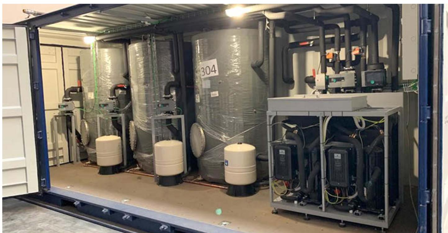
Módulo Geotérmico contenerizado. Detalle de circuitos hidráulicos y bomba de calor geotérmica.
