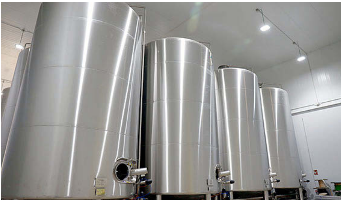
Instalaciones de la nueva planta láctea de Antequera (Málaga). ALEX ZEA
