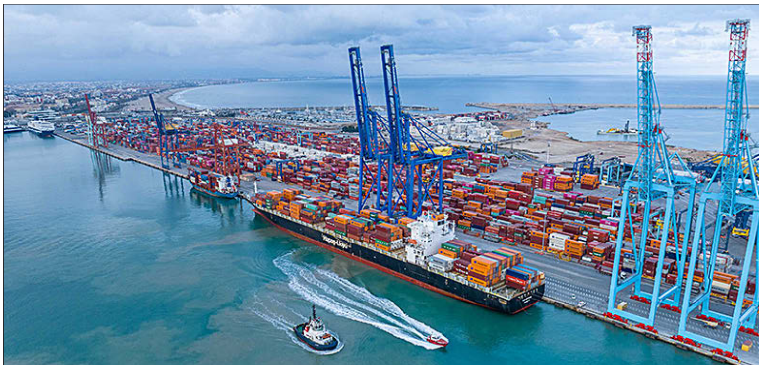
Instalaciones del Puerto de Valencia. EE
