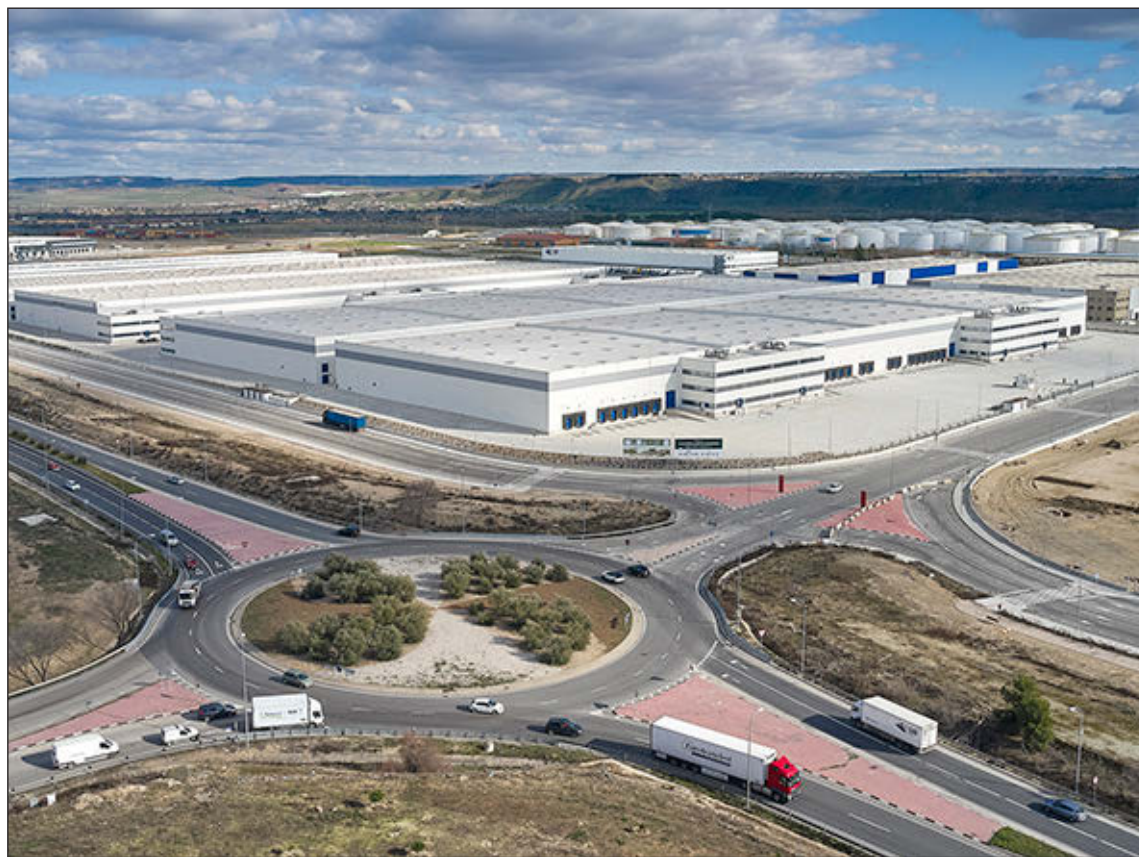
Nave logística de Prologis. EE
