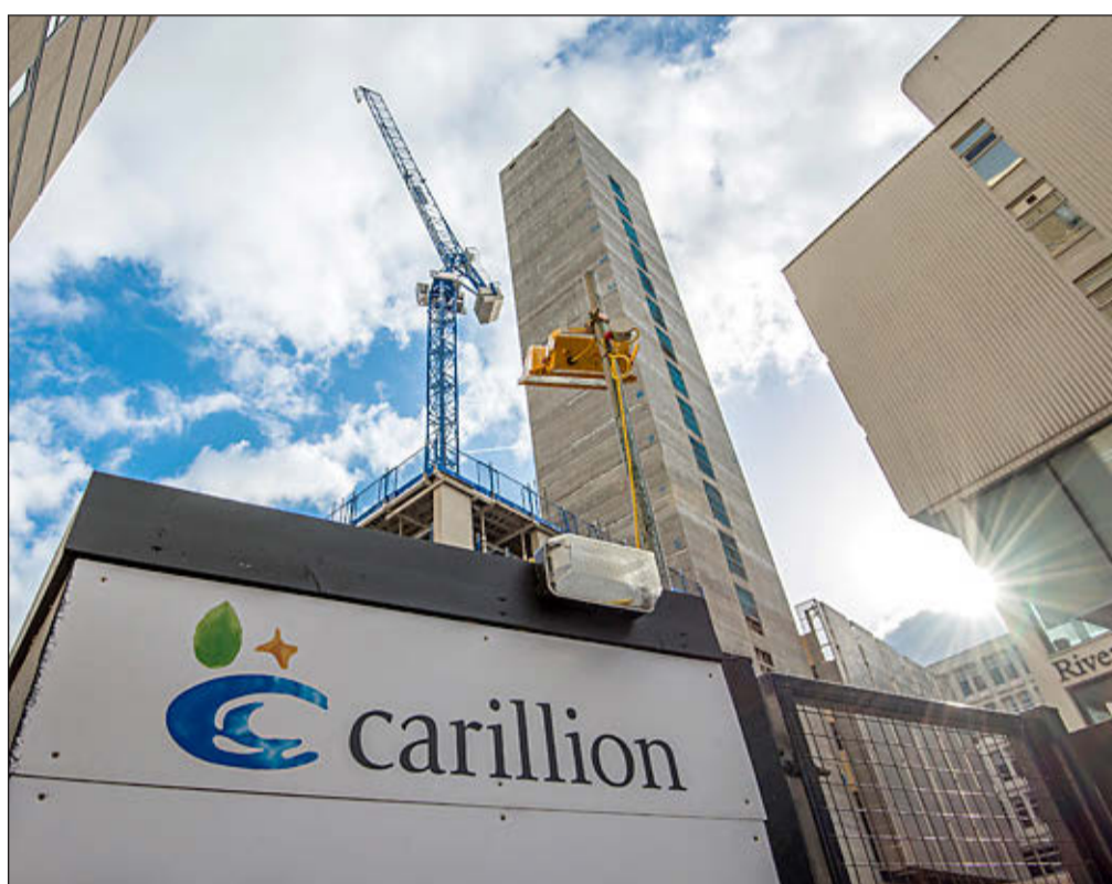
Construcción de la empresa Carillion en Reino Unido. ALAMY
