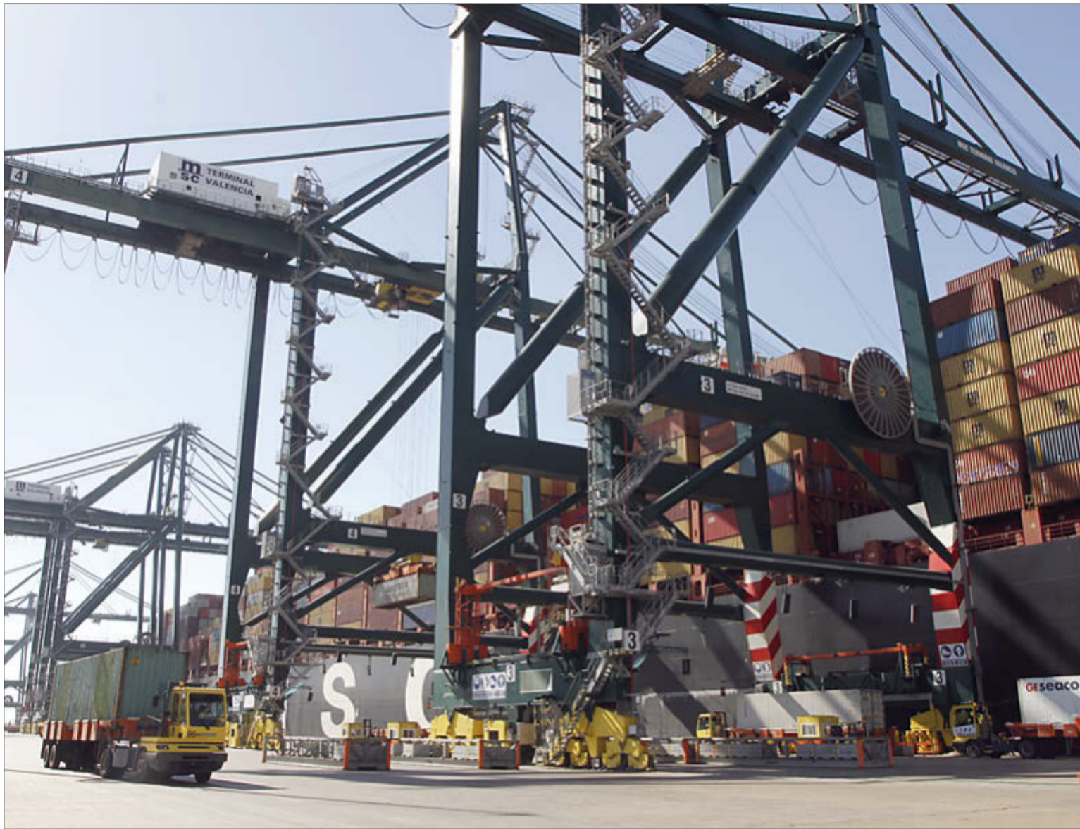
Trabajos en un muelle del Puerto de Valencia. GUILLERMO LUCAS
