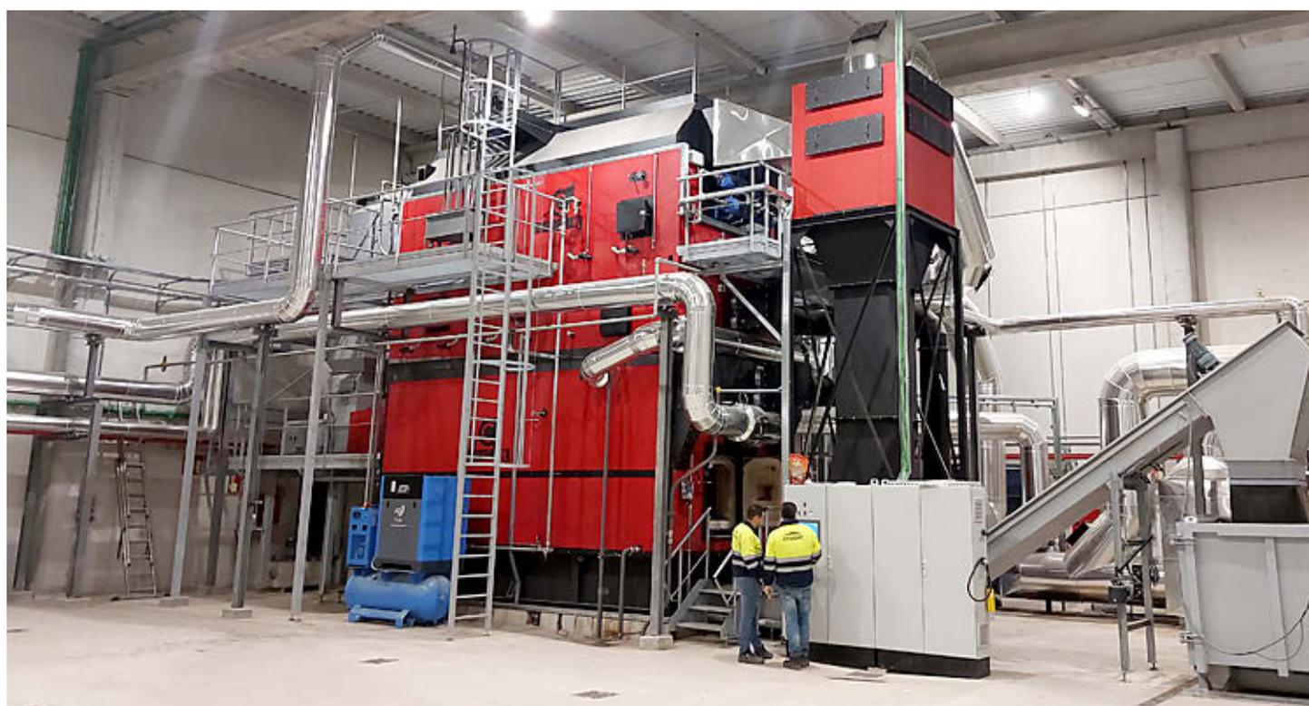
Caldera de biomasa de 4,5 MW instalada en la central de Txantrea.
