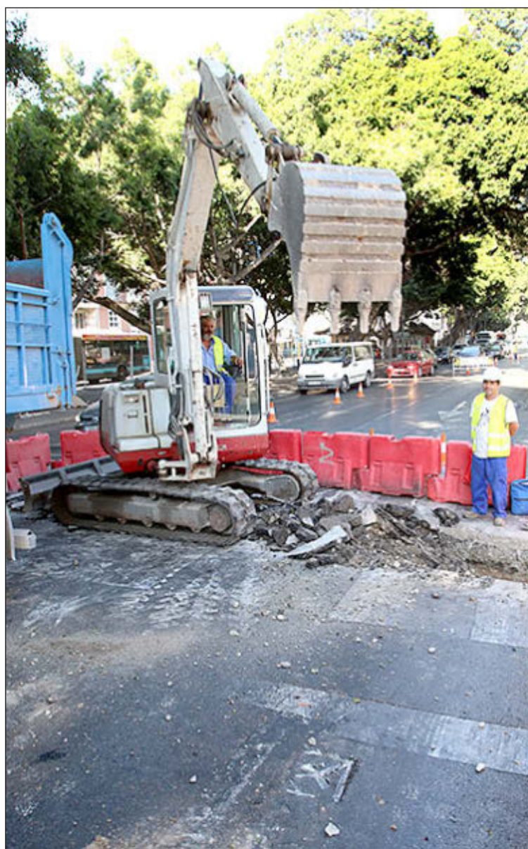
Obras del Metro de Málaga. ÁLEX ZEA
