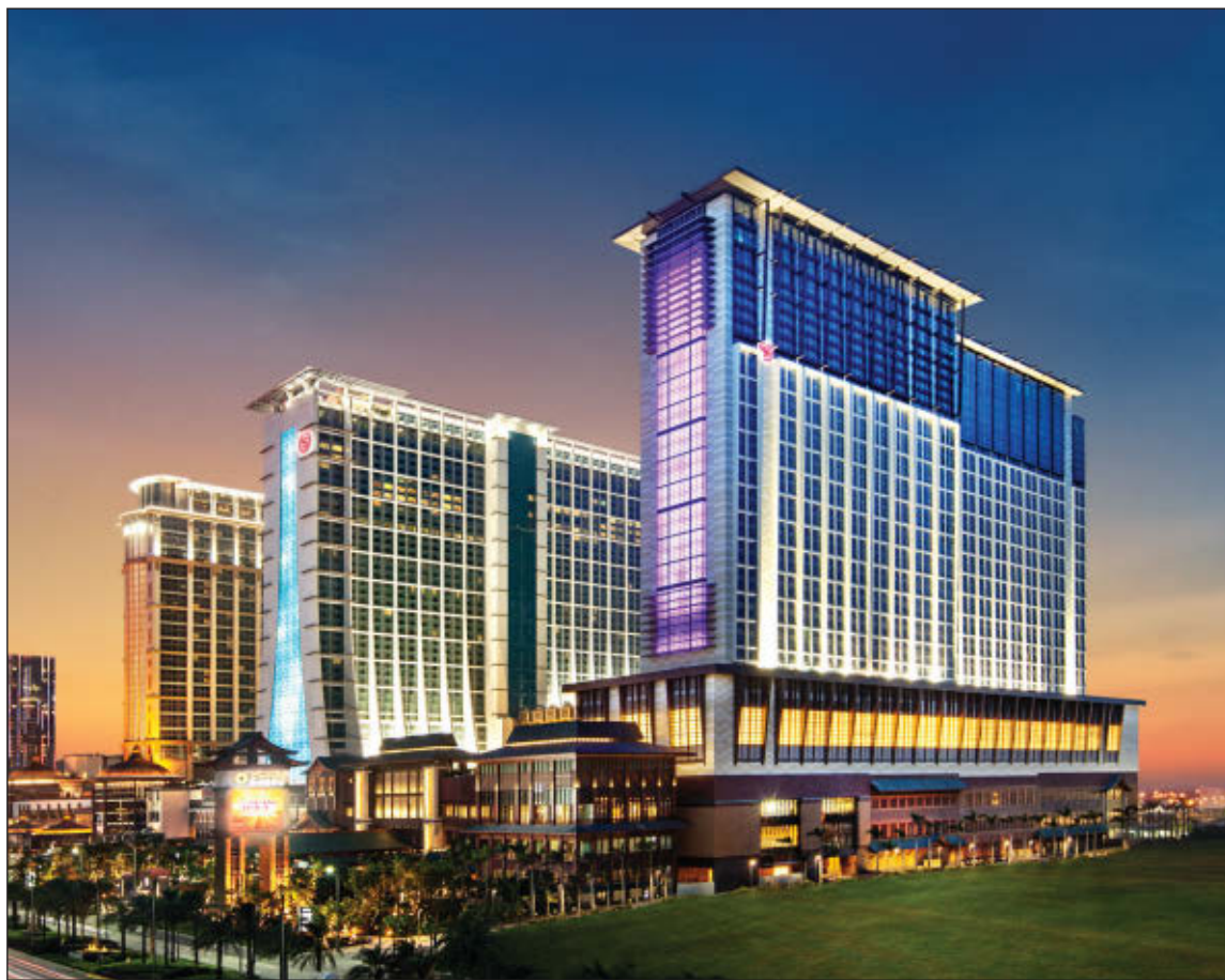
Aspecto del Sheraton Macao Hotel, el mayor establecimiento de la cartera internacional de Starwood.
